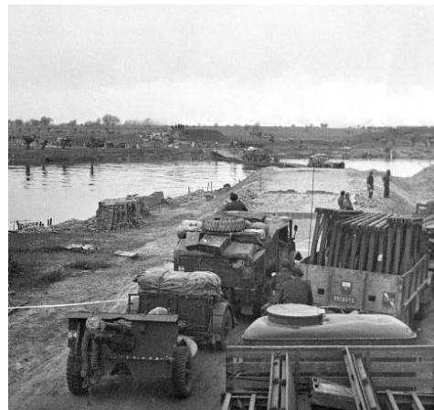
Oversteek over de gelegde pontonbrug
