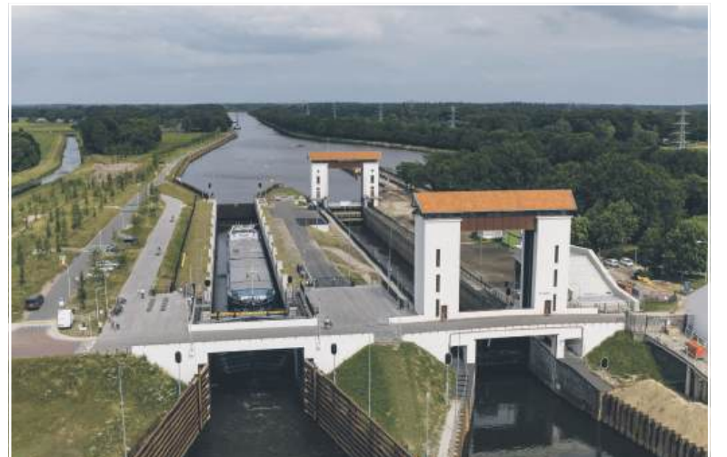
Sluiscomplex Eefde. (foto Rijkswaterstaat)
